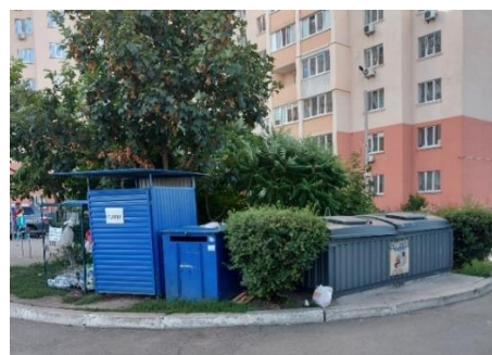
Фото. Контейнерний майданчик без огороження та накриття
