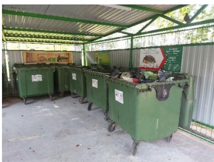
Фото. Контейнерний майданчик з накриттям та огороженням
